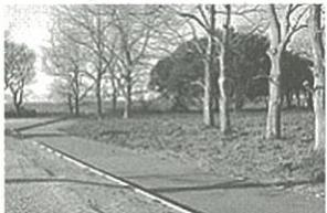
田中建材（株）は、木質に関わるリサイクル技術に熱心に取り組まれています。環境に配慮した適度の弾力性のある木質舗装材「ハーモニーロードウッド」は、過熱したアスファルトと木質（廃木材のチップ）の混合技術としては日本で初めての技術です。（エコマーク取得済）都市部のヒートアイランド予防にも効果的な製品で、廃木質の二酸化炭素を歩道部に固定することにより温暖化防止にも貢献しています。
