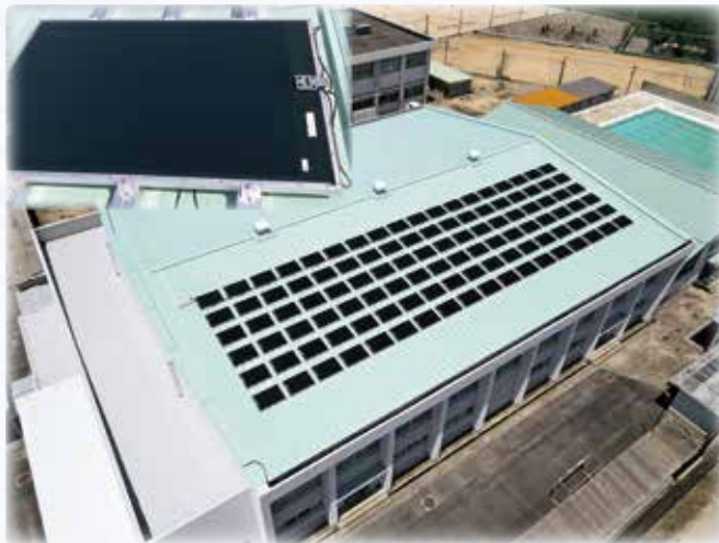
八幡工業高校体育館の屋根に導入されました
