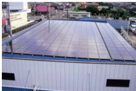
本社屋上に太陽光パネルを設置
