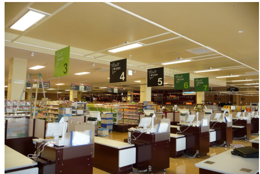
LED 照明使用事例
