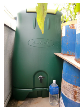
雨水利用 (雨水タンク、雨水利用システム)
