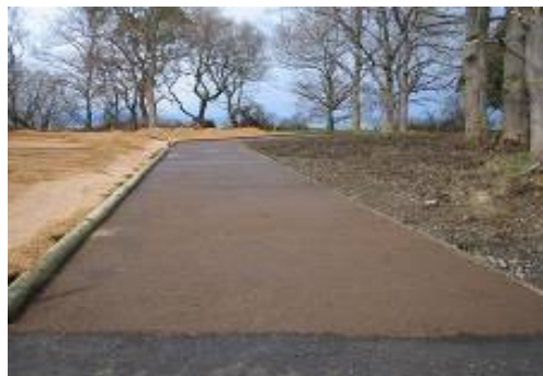
木質加熱アスファルト施工路
